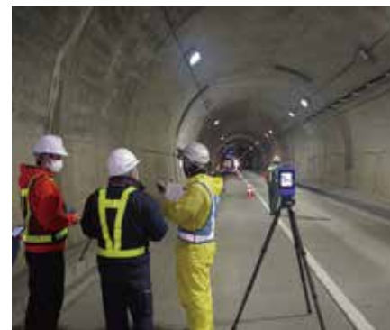
真夜中のトンネル計測
