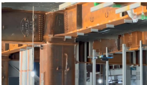
「Skydio 2+™」が自動巡回飛行している様子
