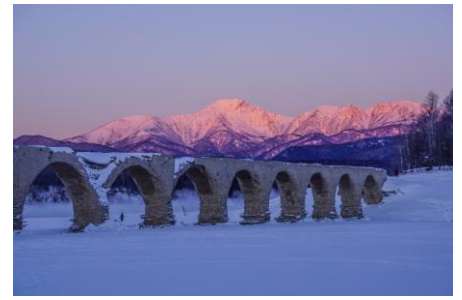
タウシュベツ川橋梁（上士幌町）
